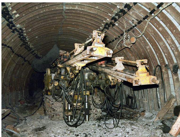
Рисунок 3.13. – Бурильная установка УБШ 313А в забое горной выработки
