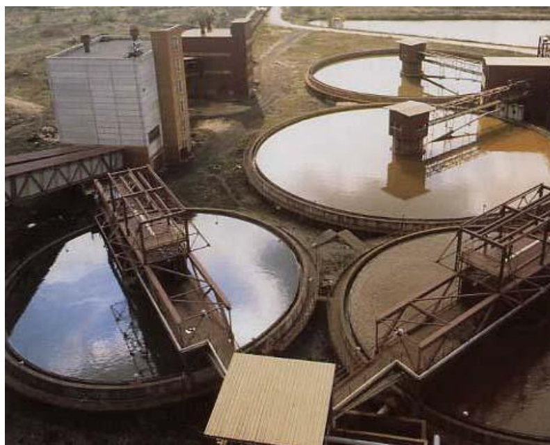
Рис. 4.1.4.2. Сгустители радиальный с периферическим приводом
