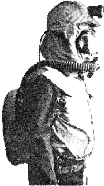
Рис. 42. Противотепловая куртка ТК-50
