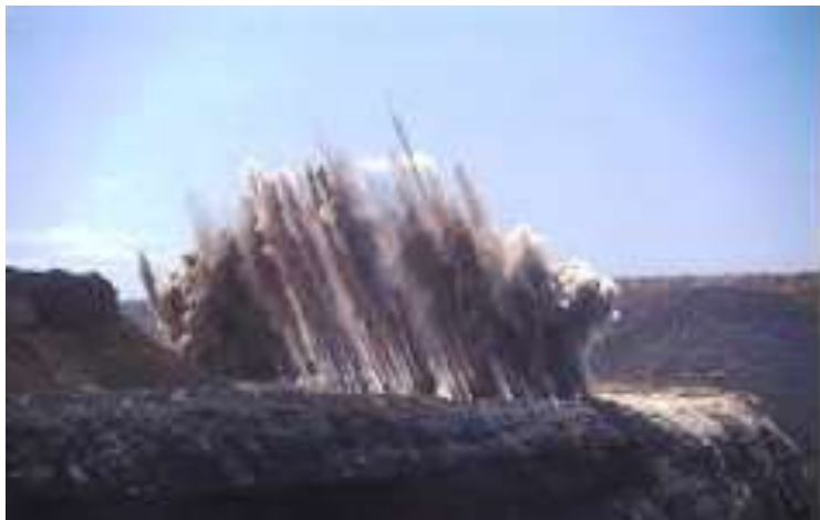
Рис. 1.13. Взрывание с предварительным щелеобразованием на предельном контуре карьера наклонными скважинами на высоту одного (а) и нескольких (б) уступов
