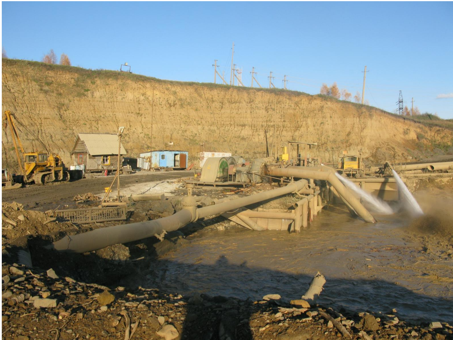
Рис. 4.3. Использование зумпфовых гидромониторов ГМД-250М на разрезе «Галдинский»
