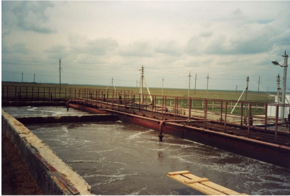
Рис. 14. Аэротенк с активным илом
