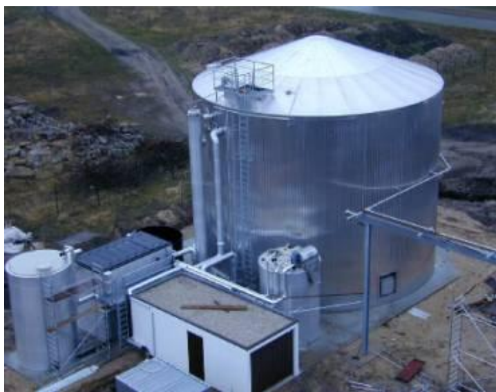
Рис. 13. Анаэробные очистные сооружения для химической промышленности
