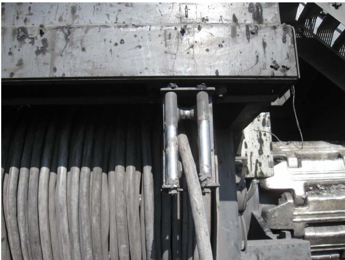
Рис. 19. Кабельный барабан и кабелеукладчик
