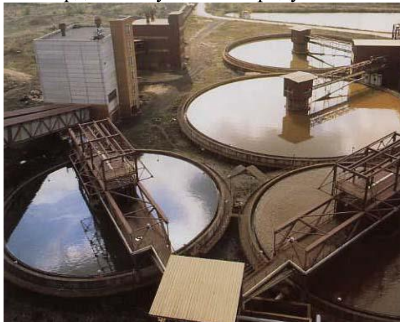
Рис. 4.1.4.2. Сгуститель радиальный с периферическим приводом
