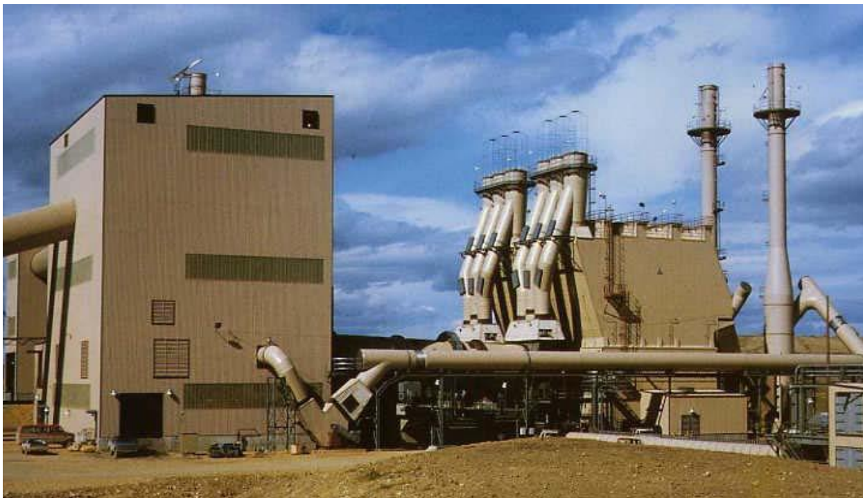
Рис. 4.1.7.1. Сушильная установка с газоочистными сооружениями на углеобогащательной фабрике (Канада)
