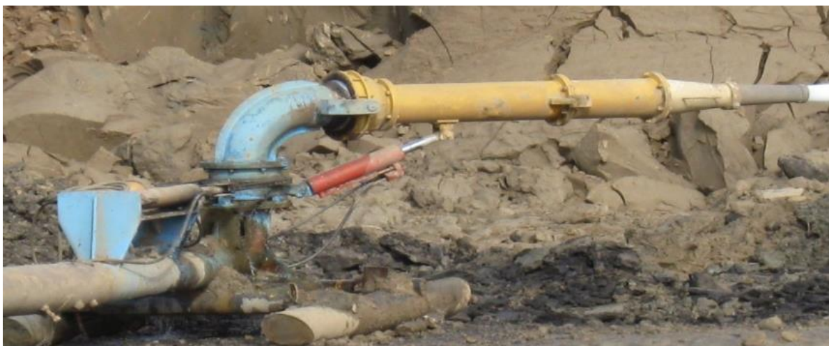
Рис. 3.2. Гидромонитор ГД-300 на Кедровском разрезе
