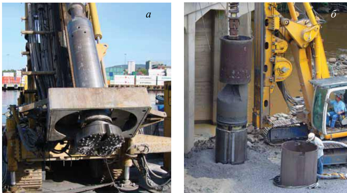
Рис. 3.9. Бурение больших скважин кластерными пневмоударниками компании Atlas Copco: а – общий вид погружного пневмоударника; б – установка обсадных труб
