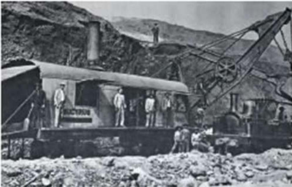
Рис. 2. Паровой экскаватор Bucyrus Foundry на рельсовом ходу (1908 г.)
