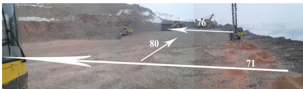
Рис. 1.4. Фото площадки обследования
