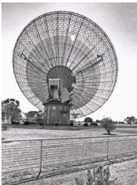
**Радиотелескопом** называют направленную радиоантенну, которая используется в радиоастрономии для приёма собственного электромагнитного излучения небесных объектов в радиодиапазоне и
