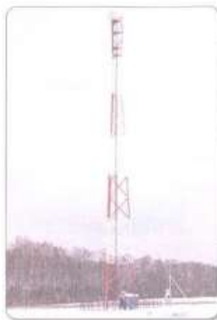
Рис. 14. Базовая станция сотовой сети (передатчик)
