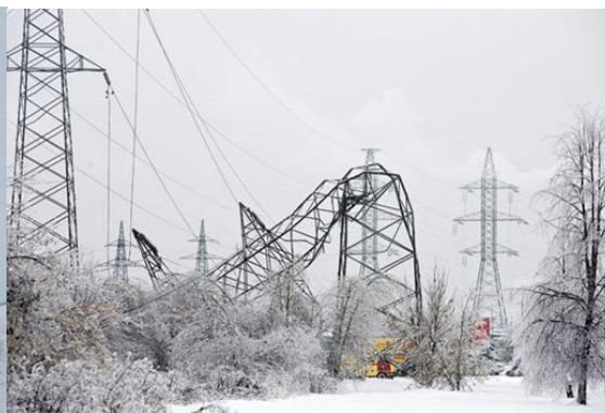
Рисунок 2. Последствие обледенения проводов
